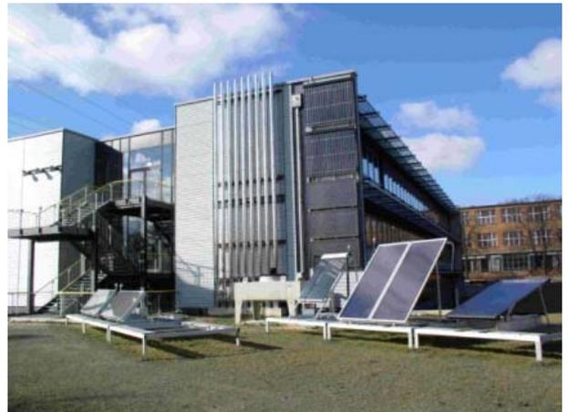
Schwerpunkte von **Modul 2** sind der prinzipielle Aufbau, die Wirkungsweise in den Grundzügen und der Vergleich von unterschiedlichen Kollektortypen einer thermischen Solaranlage. Die SuS erarbeiten sich zunächst in Gruppenarbeit den Aufbau und die Wirkungsweise einer thermischen Solaranlage. Hierbei dient der Solargarten der Max-Taut-Schule als Schulungs- und Anschauungsobjekt.
